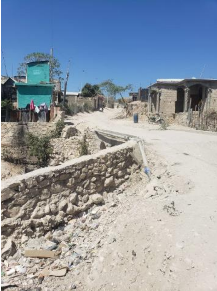
Figure 4-4 : Pont sur une ravine à Gonaïves (février 2021)
