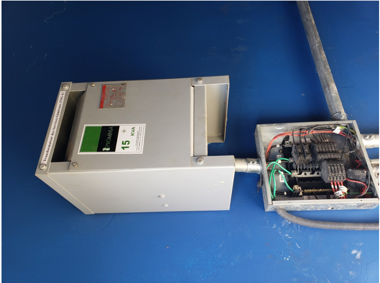
Couloir de contrôle
